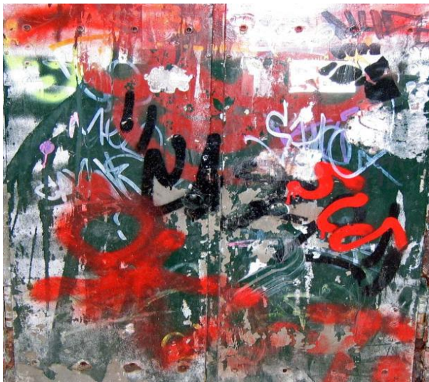
Deur van transformatorhuisje bij De Inktpot in Utrecht.
