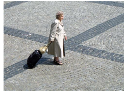
figuur 1 Sierplaveisel in segmentverband op de Grote Markt in Groningen
